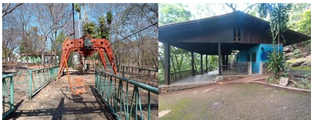
Figura 6 – Registros Teleférico e Bilheteria.
