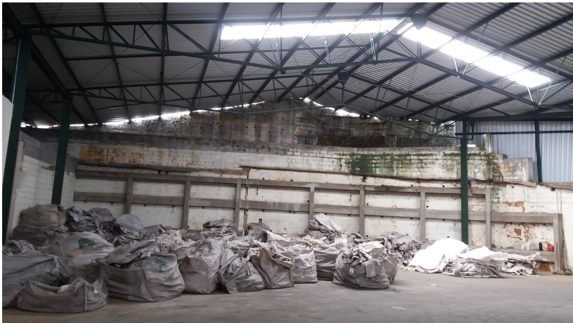
INTERIOR DO FUNDO DO PRIMEIRO GALPÃO
