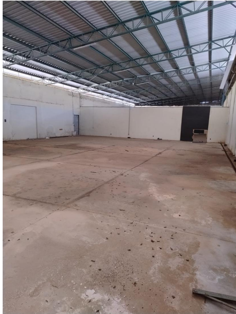
INTERIOR DA PRIMEIRA PARTE DO SEGUNDO GALPÃO
