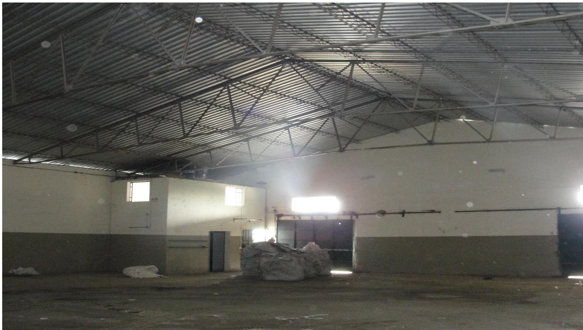
PRIMEIRA PARTE DO INTERIOR DO PRIMEIRO GALPÃO
